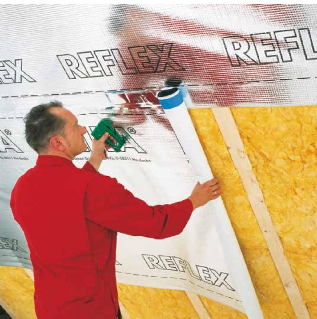
Пленки DELTA®-REFLEX/REFLEX PLUS являются универсальными пароизоляционными материалами.
